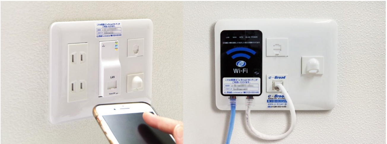
左上：(図3)埋め込み Wi-Fi 右上：コンセント型後付け Wi-Fi
